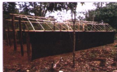
Estufa em construção (lote 87)
